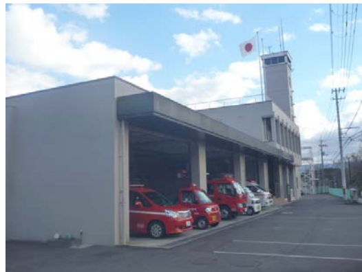
西消防署 綾川分署
